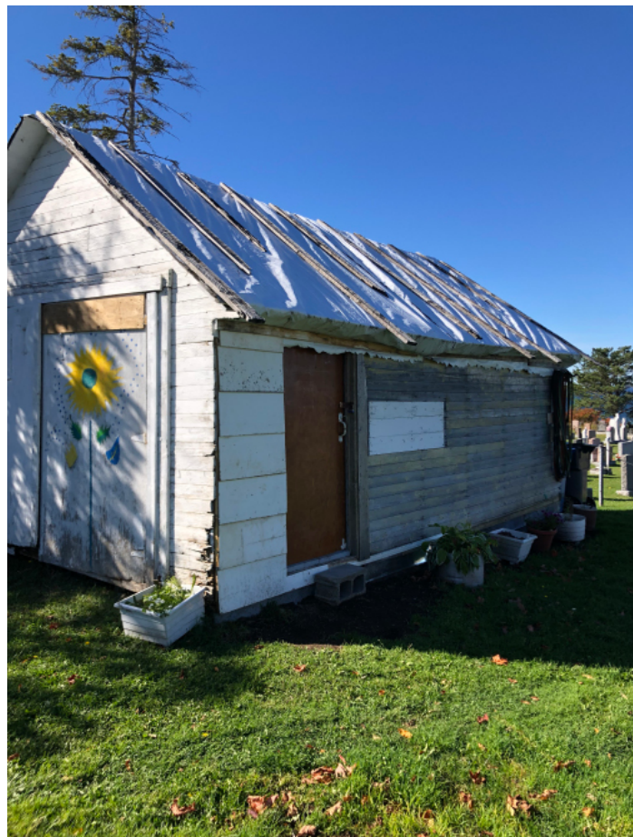
Photo après travaux
